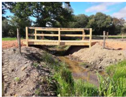
Aménagement d'une passerelle
